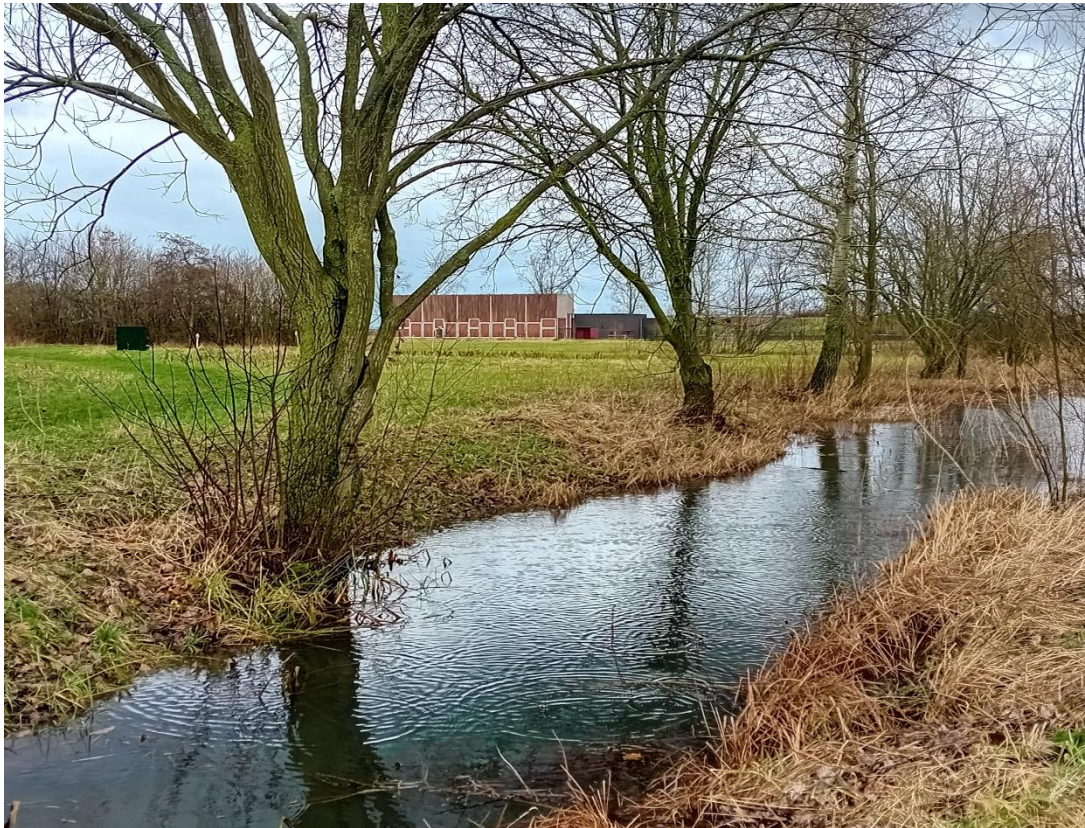
foto: Tineke Wattel. Het gebouw van Vitens en Finkersdries.
